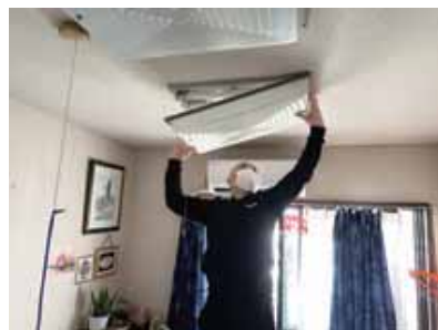
高い天井にある蛍光灯を交換
