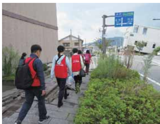
隆起した道や倒壊した建物は災害発生時のまま
